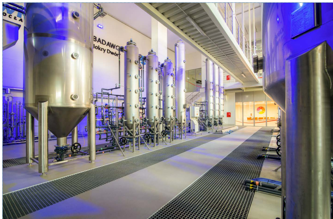
Fot. 1. Na Stacji Badawczej „Mokry Dwór” można prowadzić cały proces uzdatniania wody: od koagulacji do dezynfekcji
