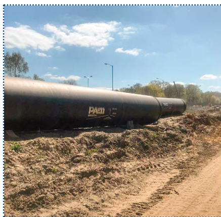
Fot. 6. Przebudowa magistrali wodociągowej DN 1400 ze stali na DN 1200 z żeliwa sferoidalnego w Katowicach w 2020 r.
